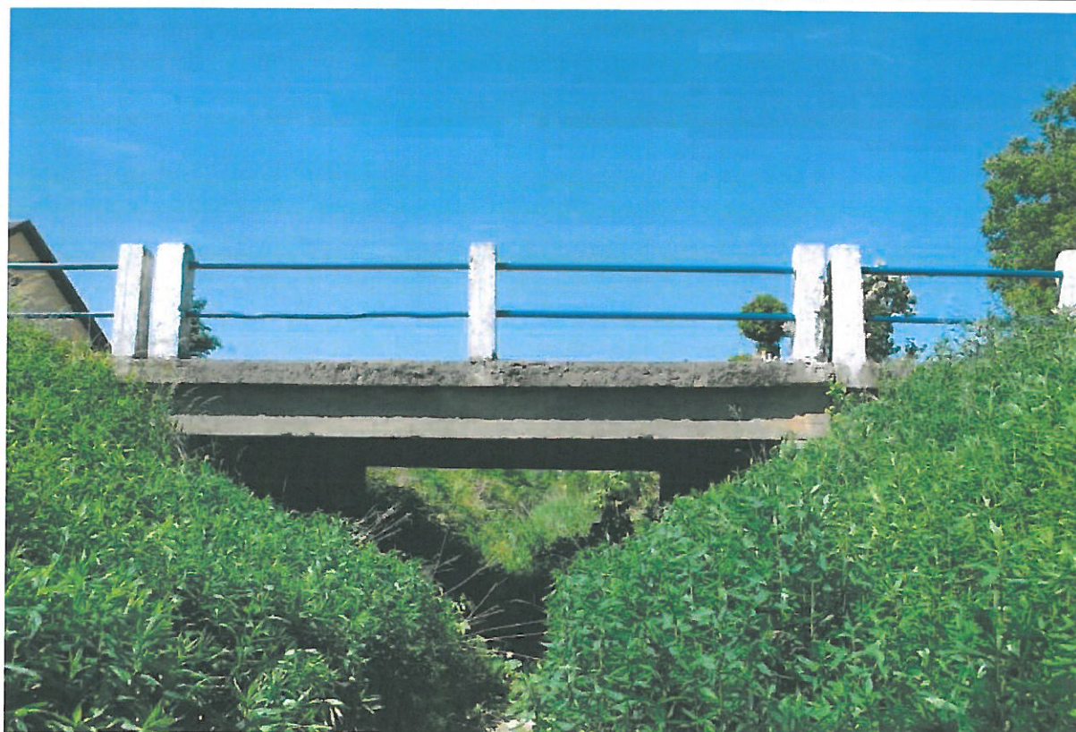
Fot. 2. Widok od strony wschodniej.
