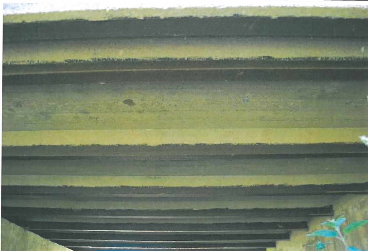
Fot. 4. Widok od spodu na konstrukcję nośną obiektu.
