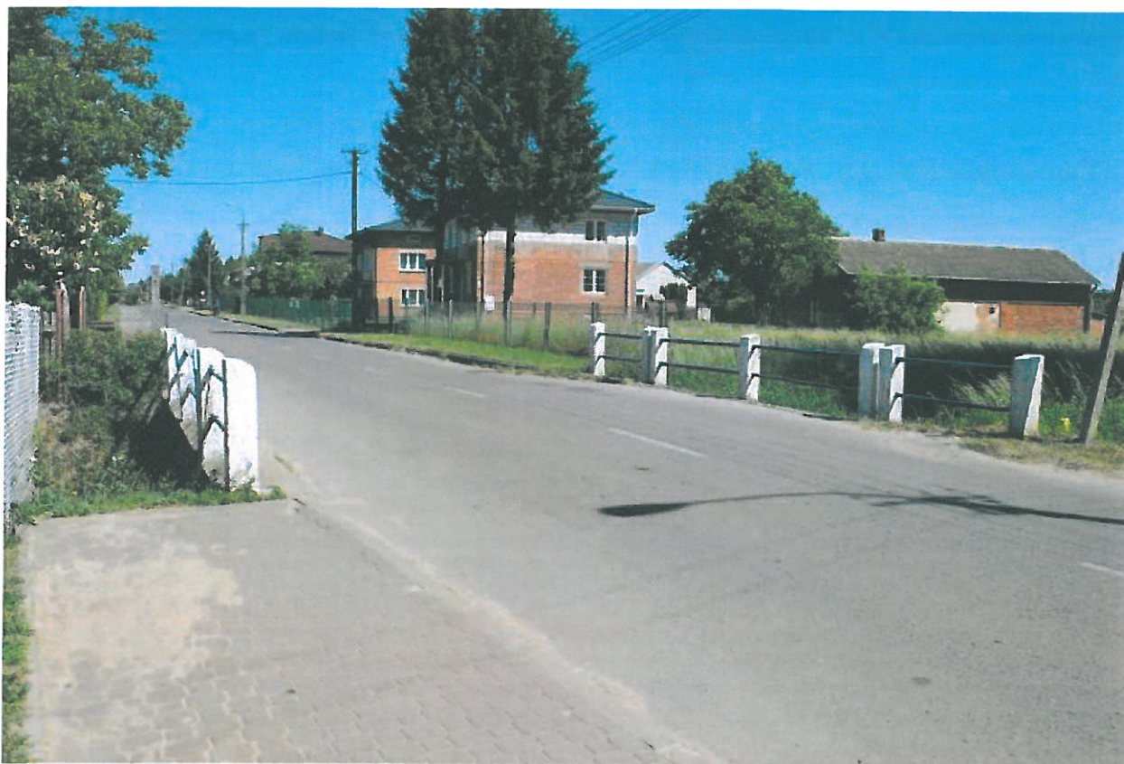
Fot. 3. Widok na od strony południowo – zachodniej.
