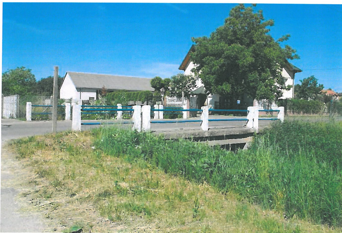
Widok ogólny mostu
